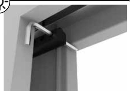
Placer la clé Allen dans le dernier trou du coulisseau pour éviter qu'il ne s'échappe lors du montage de la porte
